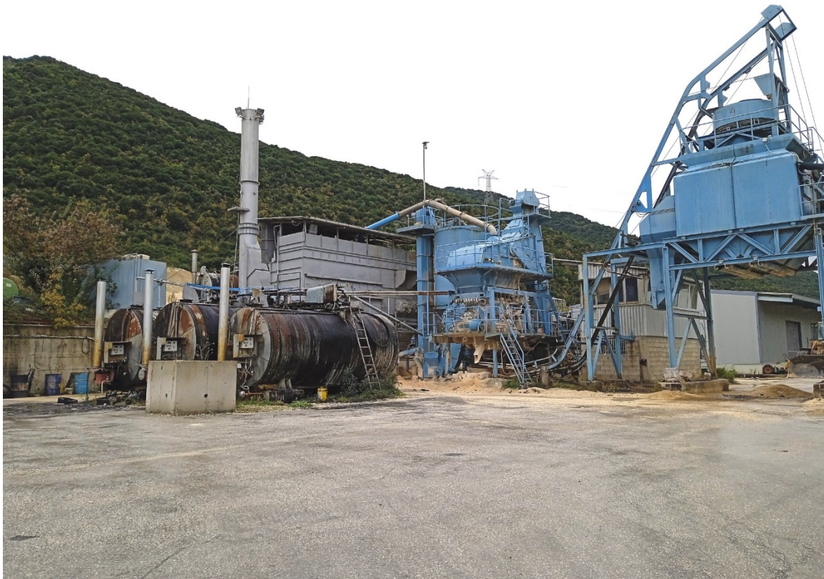
Αποκωνίαση – Ανάμιξη – Αποθήκευση
