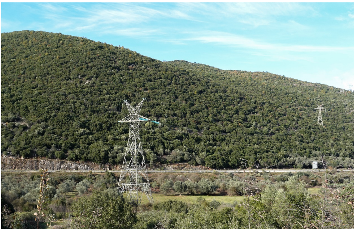
Εγνατία Οδός & Δίκτυο υψηλής τάσης στα δυτικά του έργου
