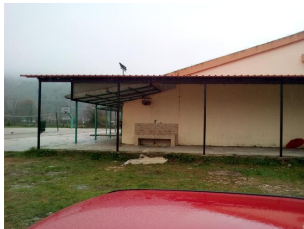
Φωτογραφία Δημοτικό Σχολείο Ξηρολόφου
