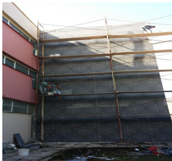
Φωτογραφία κατά την εκτέλεση εργασιών στο Γυμνάσιο Παραμυθιάς
