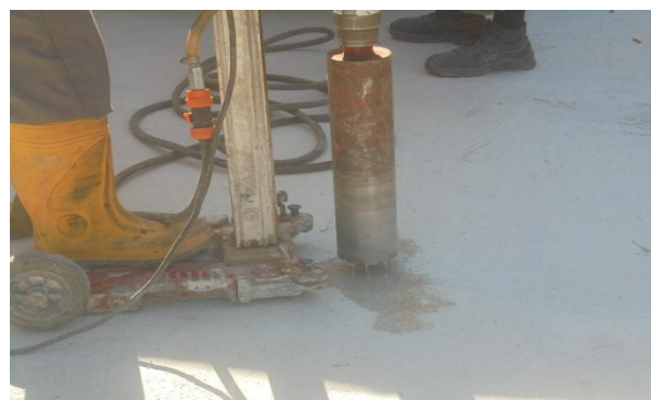
Φωτογραφία από Εργαστηριακά – Επίβλεψη για το έργο Τσιμεντοστρώσεις – Κατασκευή Τοιχίων Δήμου Σουλίου
