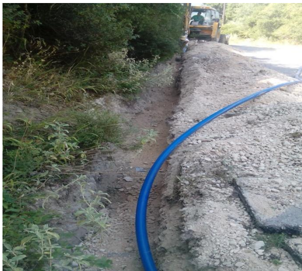
Φωτογραφίες κατά την εκτέλεση των εργασιών του έργου Αντικατάσταση Τμήματος Δικτύου ύδρευσης TK Ζερβοχωρίου
